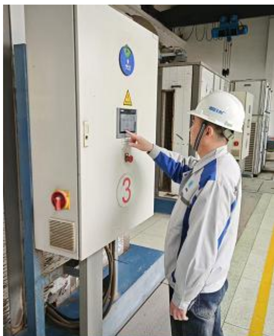
图 5：抢险组现场排除鼓风机故障
